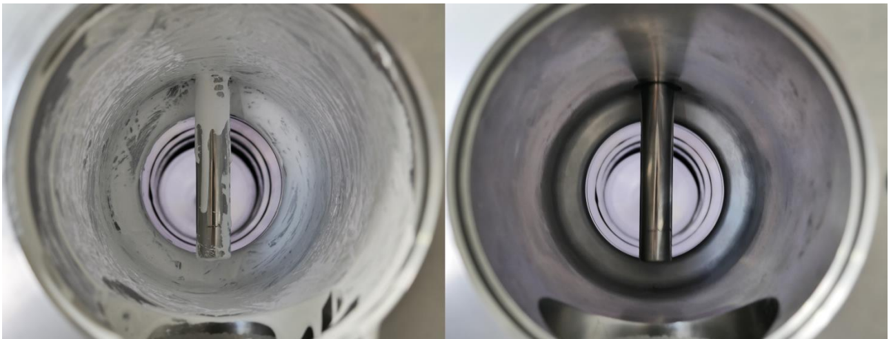
Abbildung 3: Produktleitung für wasserbasierte Farben vor und nach der comprex®-Reinigung
